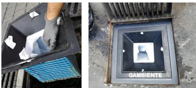
**Figura 5. Posizionamento di un sistema GRIDD all'interno di una caditoia.**
