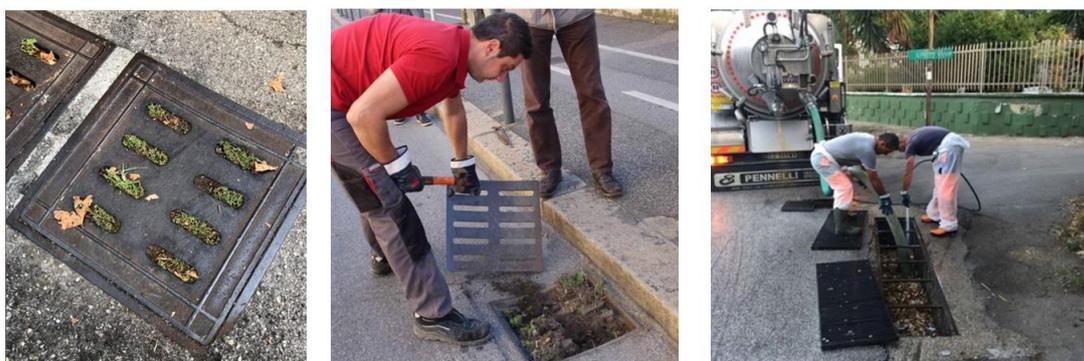
**Figura 2.** Manutenzione di caditoie saturate di sedimenti e rifiuti
